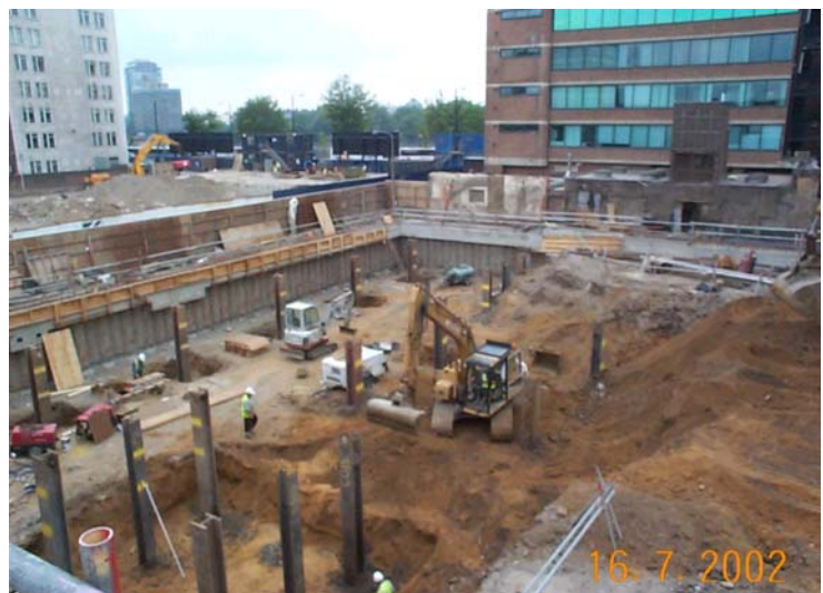
Secant Wall & Columns
