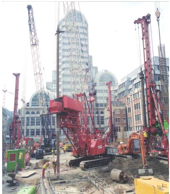
Rigs On Site
